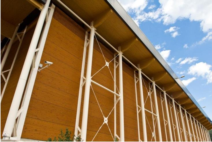
Stahlstützen und Stahlverbände in den Außenbereich verlegt
